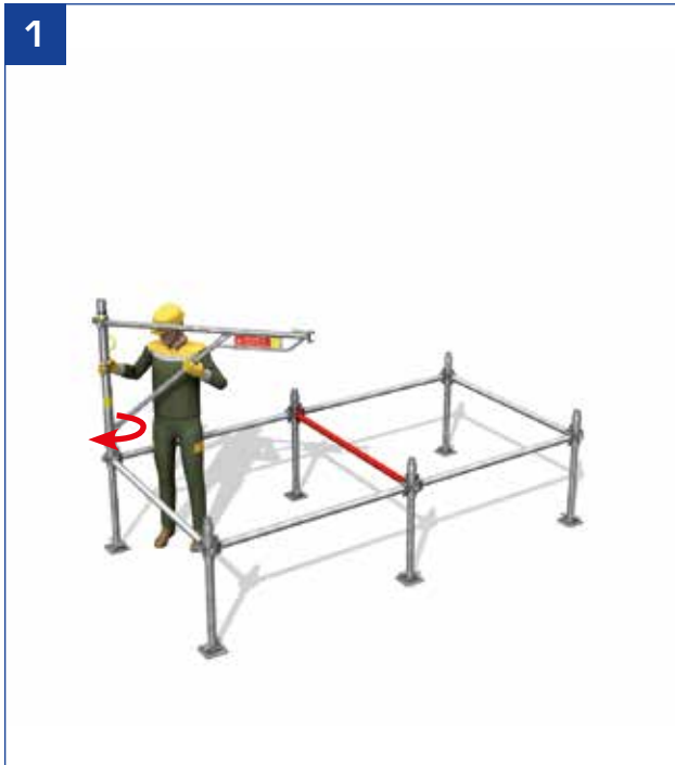
- Implantation et mise à niveau. Depuis l'intérieur de la tour, pose du 1 er cadre d'entrée dans l'axe de la diagonale puis rotation pour le verrouiller.
